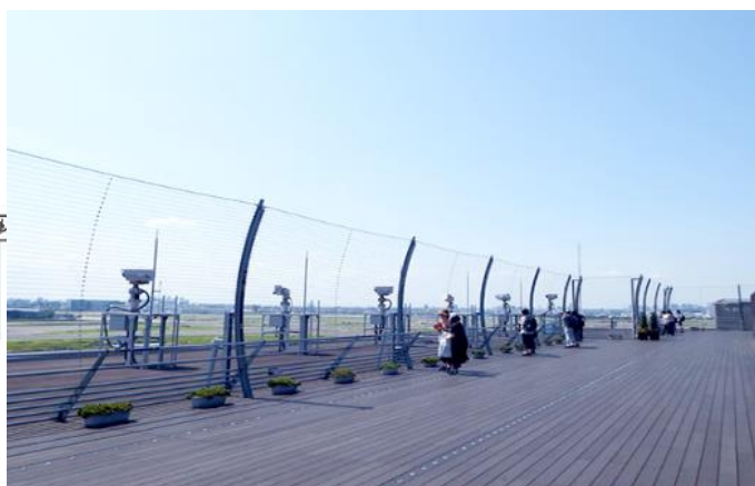
图 6.2-4 T1 航站楼 RF 屋顶观景台
